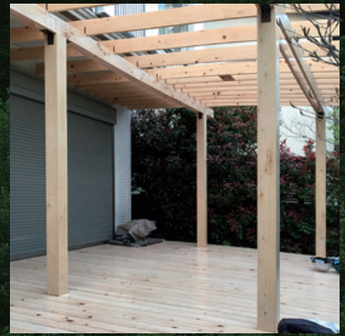
檜ウッドデッキ
